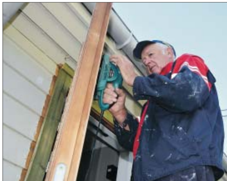
DUGNAD: 80 år gamle Andreas Skarvatun har lagt ned over 100 timar på oppussing av det gamle skulebygget.
